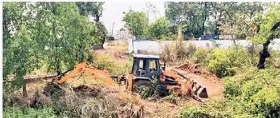
सिपहा लॉक पुल के समीप जर्जर पुल के बगल में डायवर्सन निर्माण कार्य
